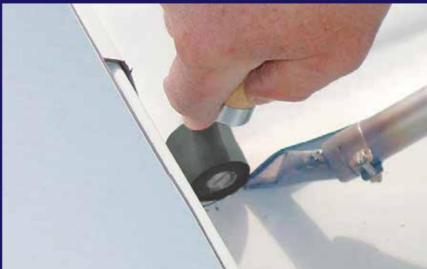
Компактный и надежный аппарат WELDY Energy 1600 для ручной сварки горячим воздухом. Набор с Energy 1600 подходит для кровельных работ, сварки внахлест полимерных гидроизолирующих покрытий и мембран (например, ПВХ, ТПО), сварки внахлест пленок и технической ПВХ-ткани. Может применяться в местах, где запрещено использование открытого пламени.
