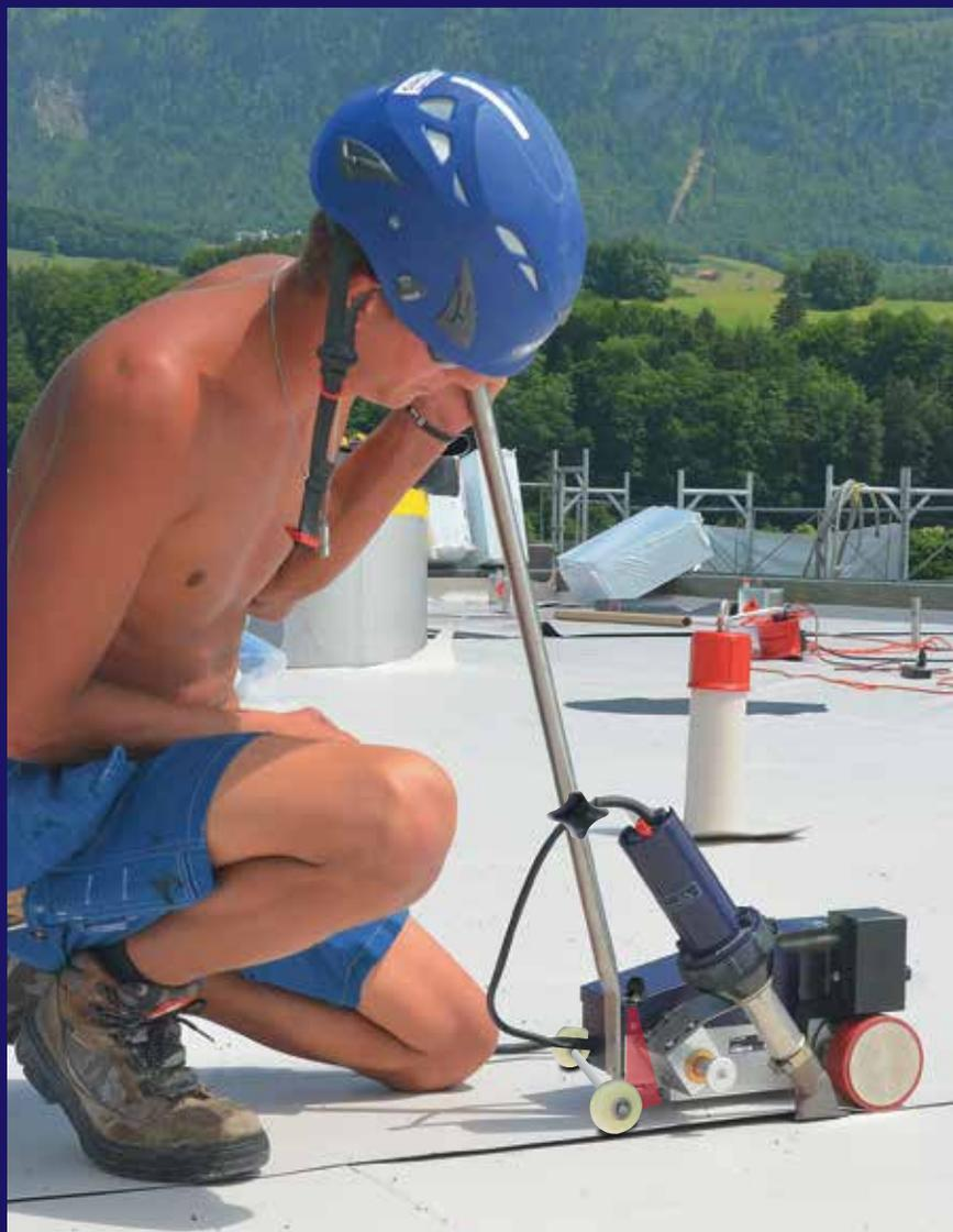
Предназначен для сварки внахлест кровельных покрытий из пластифицированного ПВХ, ЭСБ, ЭПДМ, ХСПЭ, ТПО. Может применяться в местах, где запрещено использование открытого пламени. Подходит для сварки полимерных кровельных покрытий в труднодоступных местах и при небольших объемах работ.
